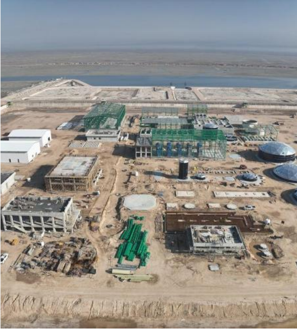
محطة معالجة المياه لمشروع المصب العام (MOD)، البصرة — أحواض المعالجة ومبانيها قيد الإنشاء.
