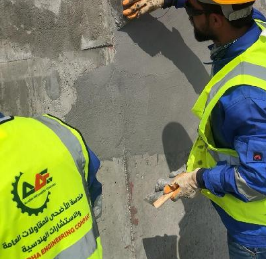
أعمال ترميم الخرسانة ومعالجة الأسطح.
